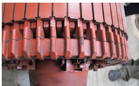
Rys. 3. Uszkodzone uzwojenie wirnika silnika trakcyjnego [1]
