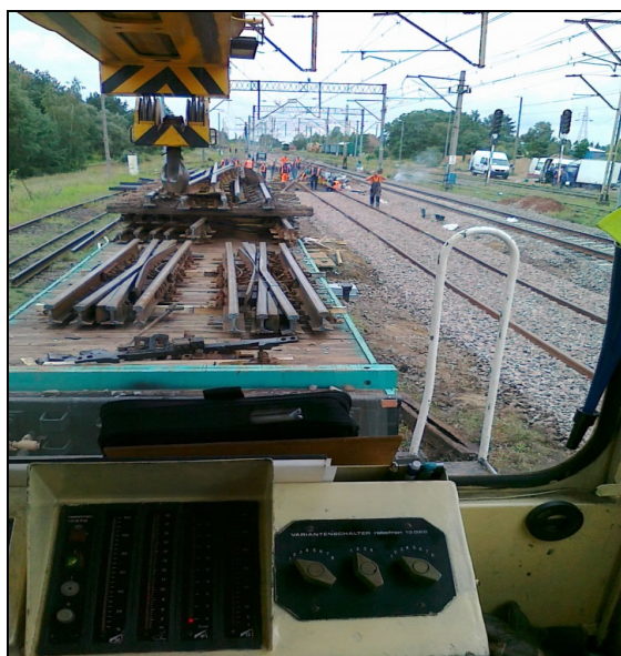
Fig. 4. Rail crane ZU-EDK-300 during track work Rys. 4. Żuraw kolejowy ZU-EDK-300 w trakcie wykonywania prac torowych
